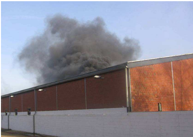
Abb. 74: Deutlich ist die schwarze Rauchsäule über dem landwirtschaftlichen Anwesen zu sehen, die den Einsatzkräften bereits auf der Anfahrt von Weitem den Weg wies.
