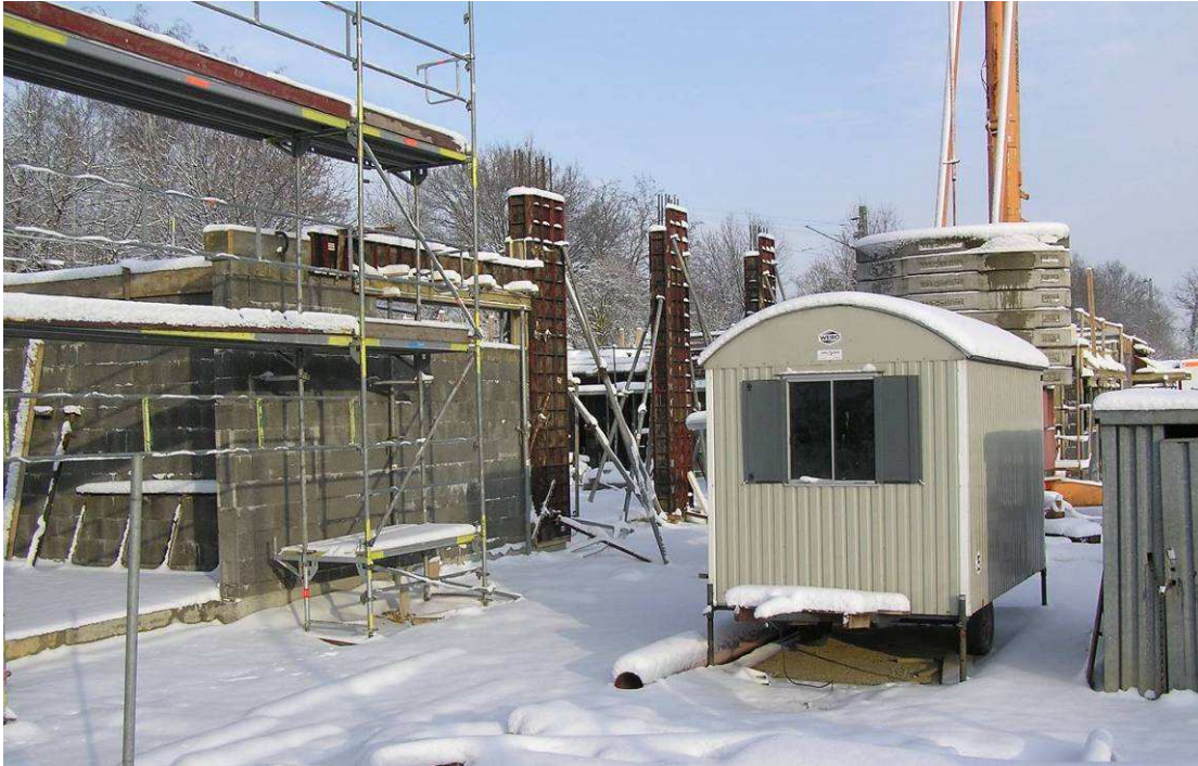
Abb.52: Baustelle des Feuerwehrgerätehauses Krefeld-Oppum im Januar 2011
