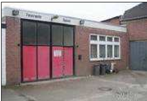
Abb 11: Das alte Gerätehaus der FF Oppum...
