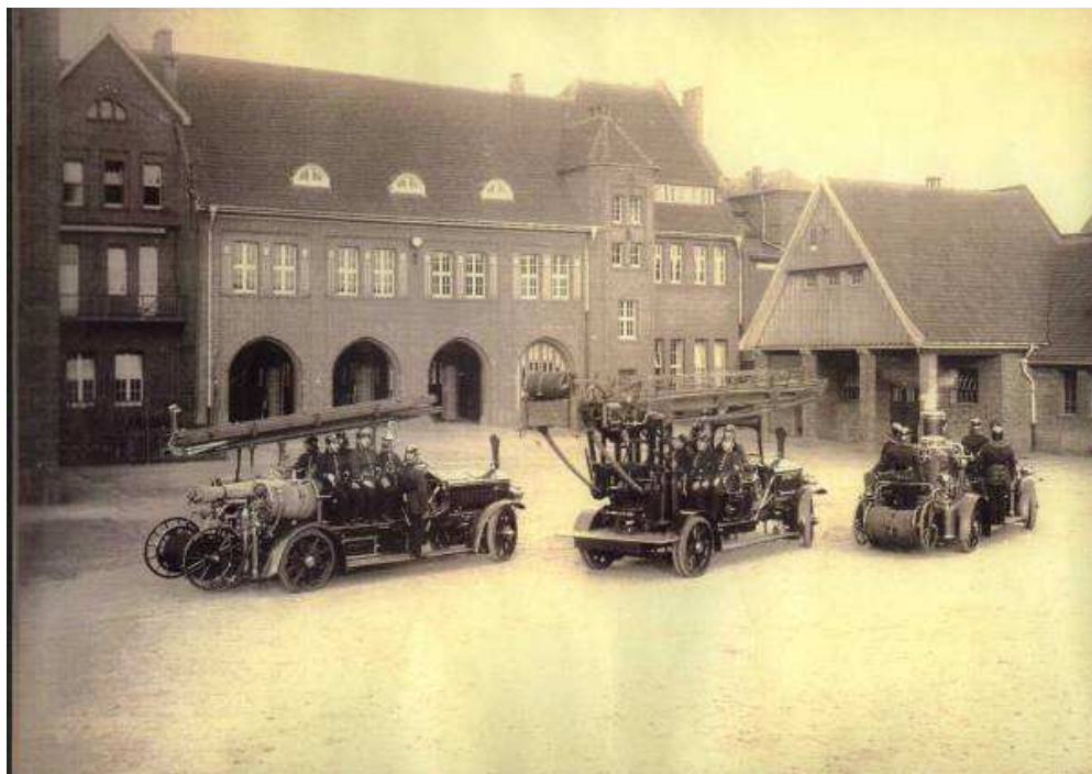
Abb. 2 Historischer Löschzug im Innenhof der Hauptfeuer- wache an der Florastrasse
