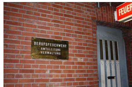
Abb. 9 Eingang auf der Florastrasse
