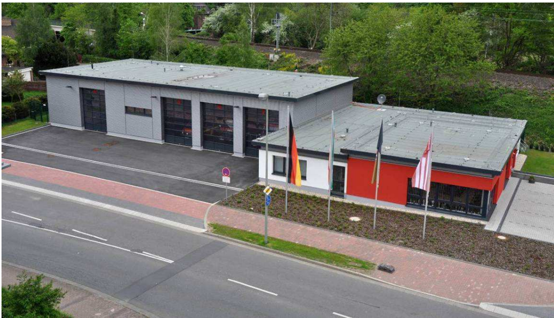
Abb. 53: Fertiges Feuerwehrgerätehaus Krefeld-Oppum
