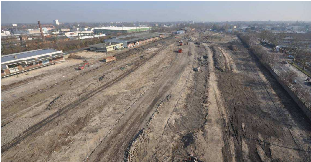
Abb.49: Das Grundstück an der Ritterstrasse während der Abrissarbeiten
