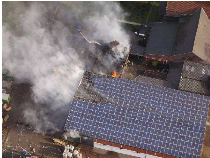
Abb. 76: Deutlich ist die gesamte Dachbedeckung mit der Photovoltaik-Anlage zu erkennen. Eine gezielte Brandbekämpfung von oben wird hierdurch erheblich beeinträchtigt und die statische Bewertung der Grundkonstruktion erschwert.
