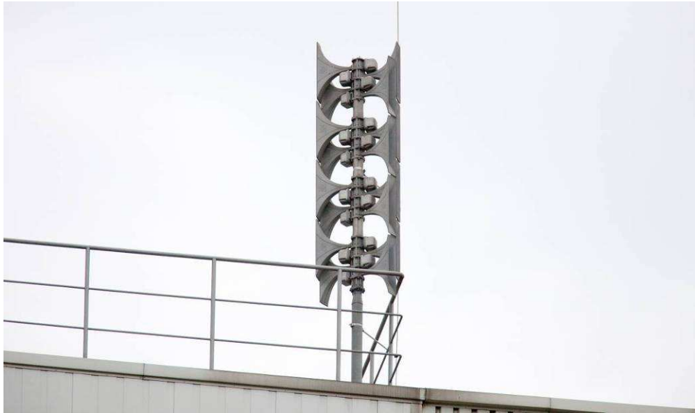
Abb.48 : 2400 W Sirene auf dem Gelände der Evonik Stockhausen GmbH Foto: Feuerwehr und Zivilschutz
