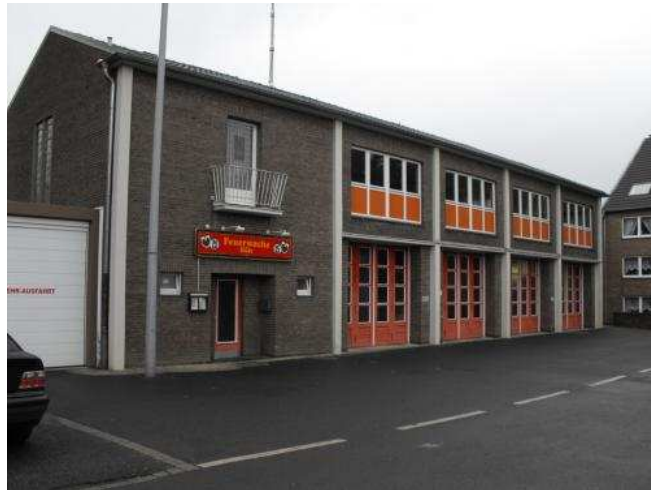
Abb. 20: Gerätehaus FF LZ Hüls
