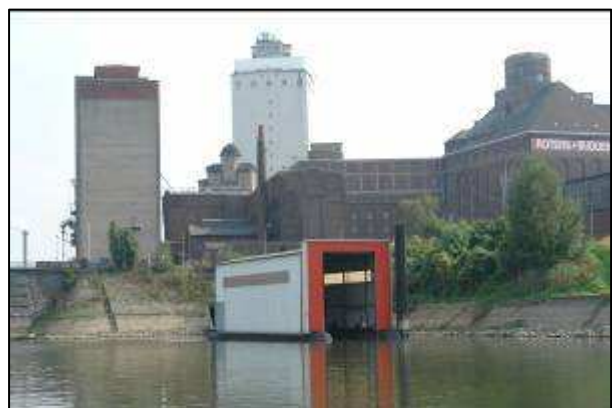
Abb. 16: Halle des Löschbootes im Krefelder Hafen
