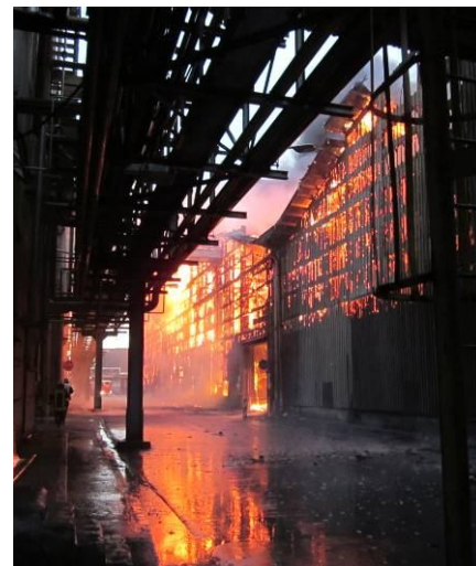
Abb. 56 Brand der hölzernen Außenfassade. Die sehr starke Wärmeübertragung birgt eine große Ausbreitungsfahr
