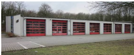
Abb. 17: Das Gerätehaus der FF Uerdingen mit aktuellem Fahrzeugpark auf dem Gelände der Feuerwache 2
