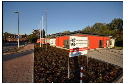
Abb. 10: Das neue Gerätehaus der FF Oppum
