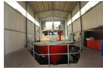
Abb. 14: Halle des Löschbootes im Krefelder Hafen
