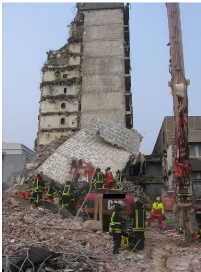
Abb.: 41 Herabgestürzte Wand auf einem Bagger. Die Einsatzkräfte arbeiten fieberhaft an der Rettung des Schwerverletzten.
